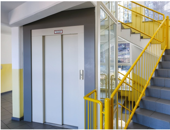
Aufzug im Haus
