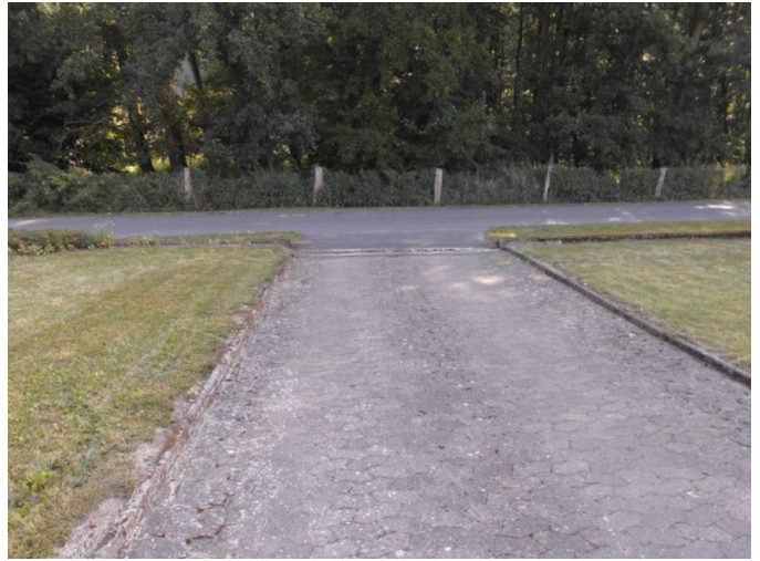
Einfahrt von der Seitenstraße
