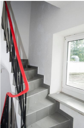
Treppenaufgang zu Schlafräumen 1 WHG 3
